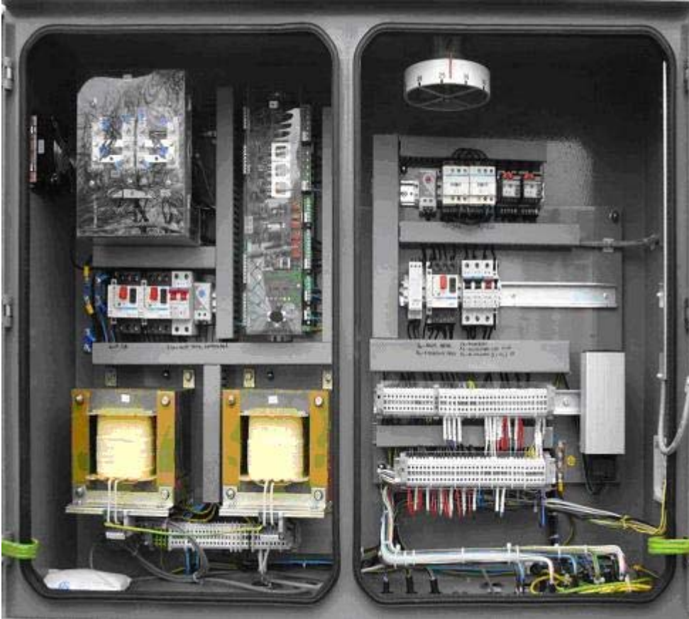
Рис Ошибка! Стил ь не определен..1: Привод для катушки Петерсена с узлом ввода/инъекции тока
