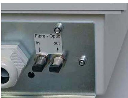
Рис. Ошибка! Стиль не определен..46: присоединение/вывод ST
